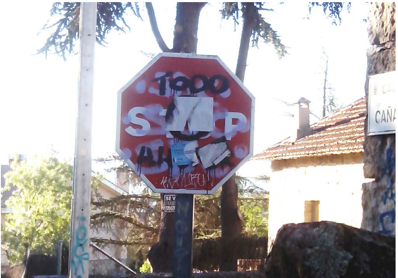
Irreconocible señal en un cruce peligroso junto a una zona escolar
